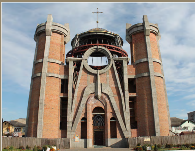
Храм Покрови Пресвятої Богородиці у процесі будівництва
